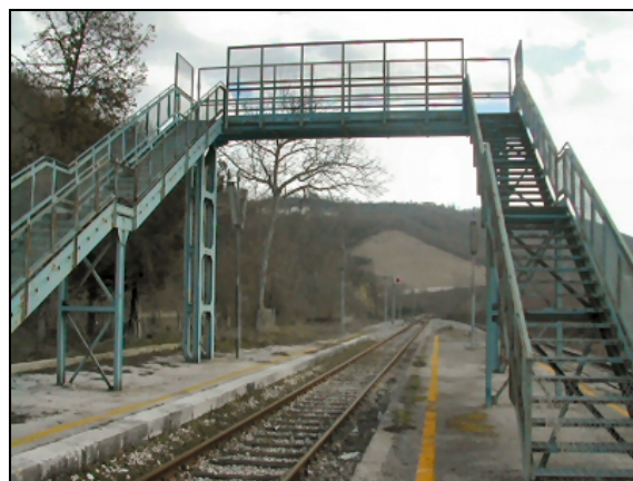
...il passaggio sopra elevato...
