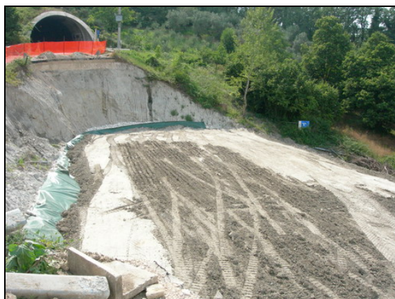
...l'area del vecchio manto stradale...
