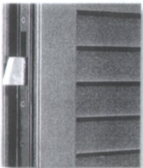
1 Serratura a tre catenacci basculanti, in acciaio, del tipo a cassa-forte.
